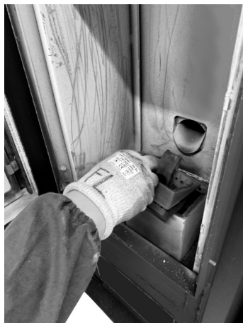
Fig. 33 - Verwijdering vuurpot
